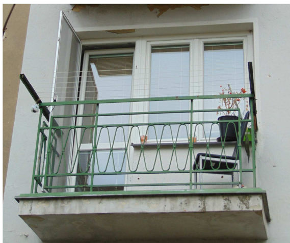
typ stávajících balkónů, včetně typu a způsobu kotvení balkónového zábradlí
