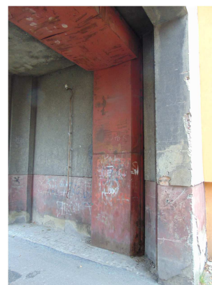
průjezd Štefánikova 320 + plechový kryt přívodního potrubí ÚT
