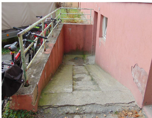
stav povrchů venkovní betonové rampy a navazujících svislých konstrukcí-sjez do 1.PP č.p.322
