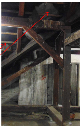
poškozená podkladní lepenka v ploše střechy
