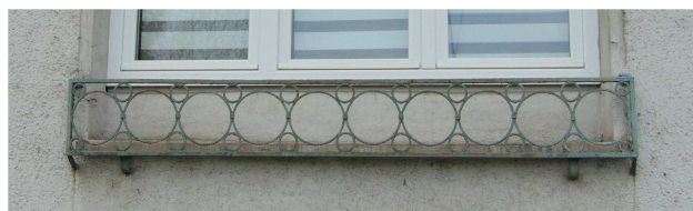
kryt květinového truhlíku-demontovat prostor za krytem dozdít až po okenní parapet
