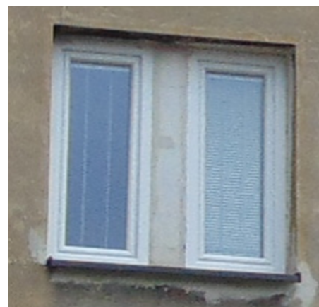
okno ve dvorní fasádě -hladká omítka, šambrána jen v barvě
