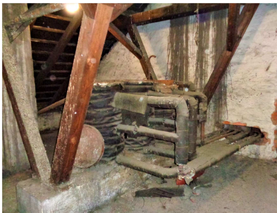
expanzní nádoby a nefunkční potrubí ÚT určené k odstranění
