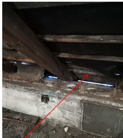
bednění nad římsou pod podokapním žlabem
