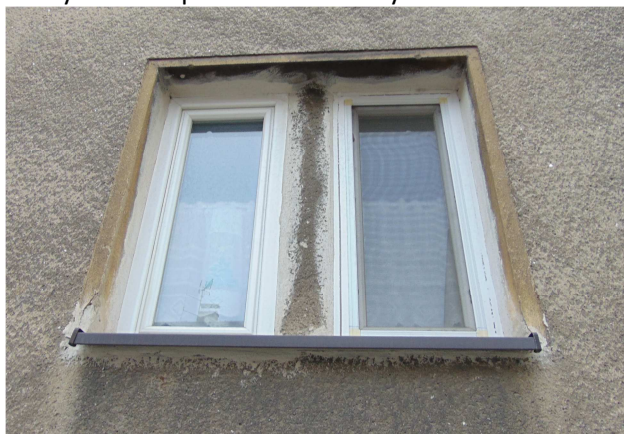
okno v uliční fasádě -březolit, zapuštěná šambrána
