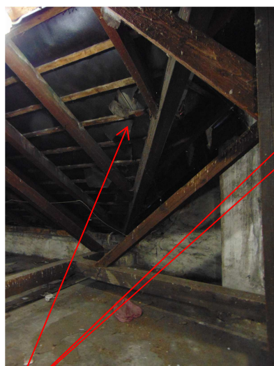
poškozená podkladní lepenka v ploše střechy
