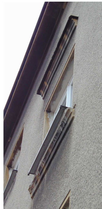
tvar říms-zachovat, vyspravit
